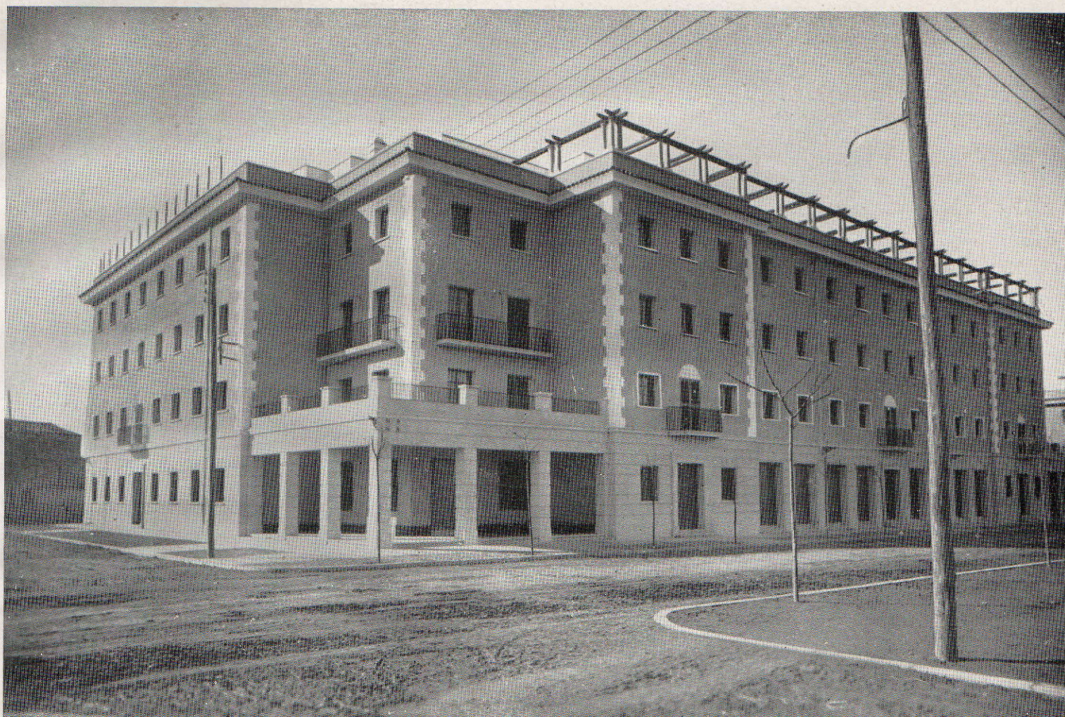
Vista general del bloque.
