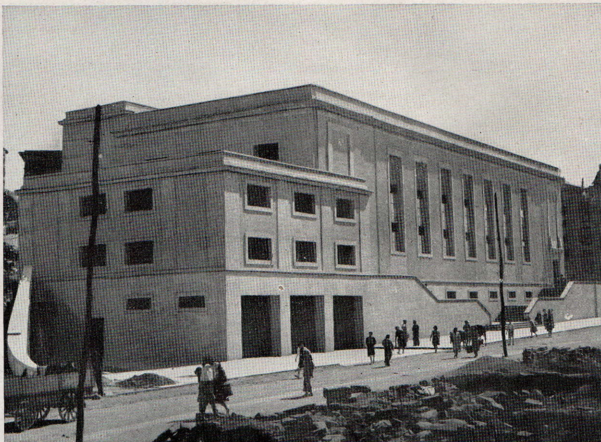
EIBAR.—Mercado. Fachada principal.
